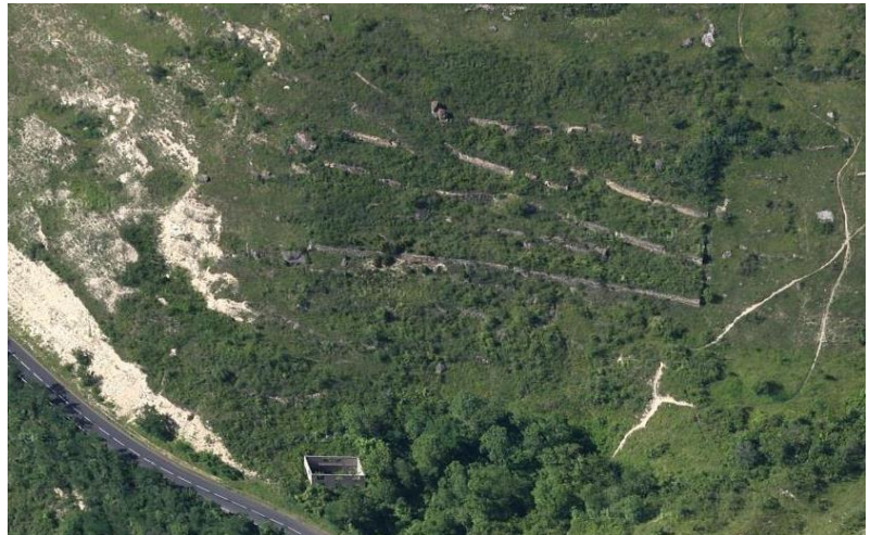
Traces encore visibles des murets retenant les pailhas
